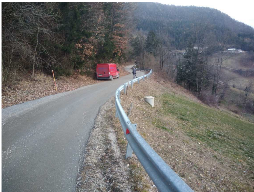
Slika 10: Pogled na plaz
