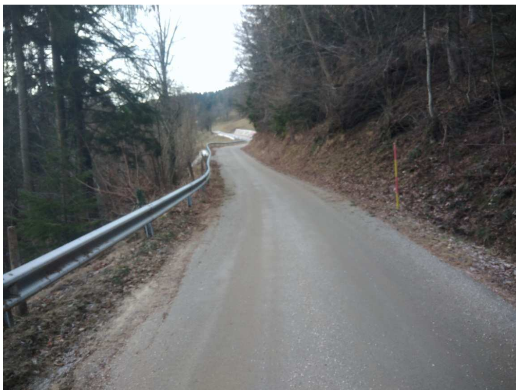
Slika 9: Pogled na plaz
