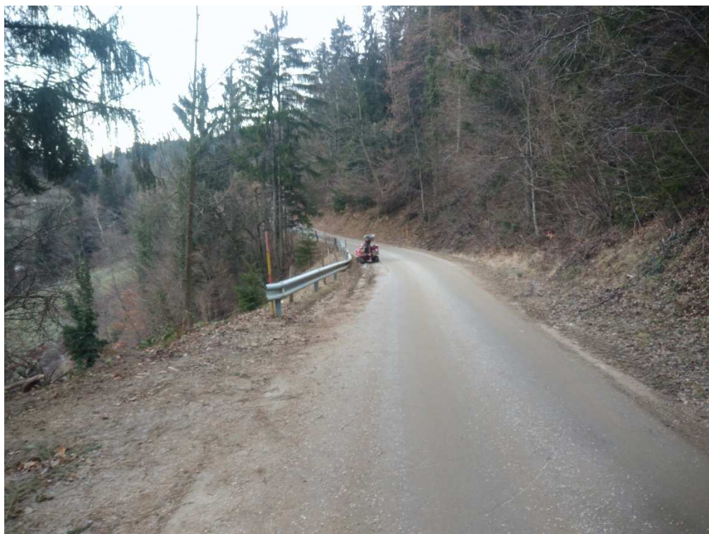
Slika 8: Pogled na plaz
